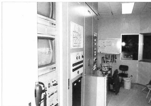
管理室・モニターを見ながらドア操作ができます
