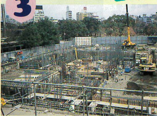
3 プールと建物を建てていきます。
