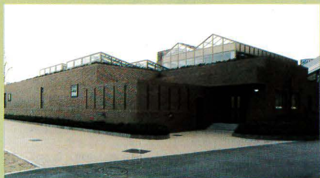
2階部分には動物養生のための予備室も設置
