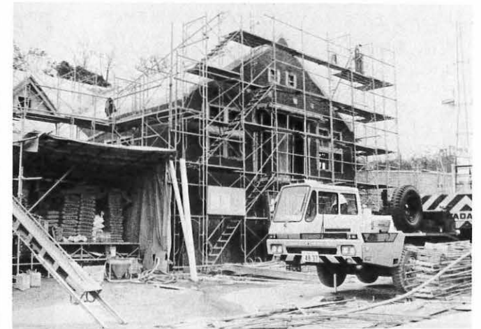
今夏オープンのコアラ舎建設も着々と進んでいます。(2月中旬撮影)
