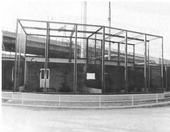
セイランとマクジャクの部屋は間口5.4m、金網はカラーステンレス、防鼠対策に土間の中ほどにはガラス碎片やステンレス金網が。
