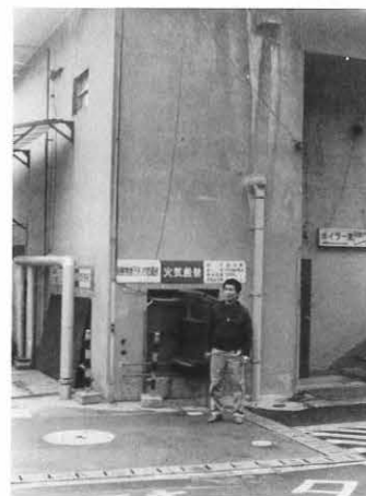
ボイラー室の前で
