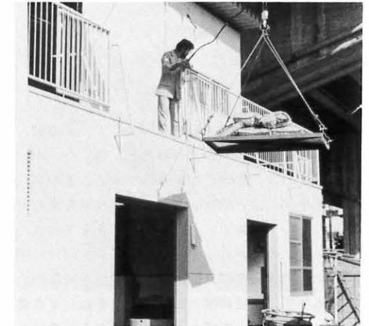
2階の倉庫にはペレット類、穀類などが収蔵されており、ホイストを使って搬入します。
