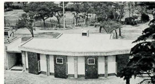
◎ 冷房 ペンギン舎
