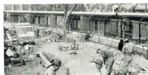
おおかみ舎 <昭和40年完成>
